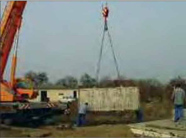
Putting the filled lysimeter vessel in ist place
